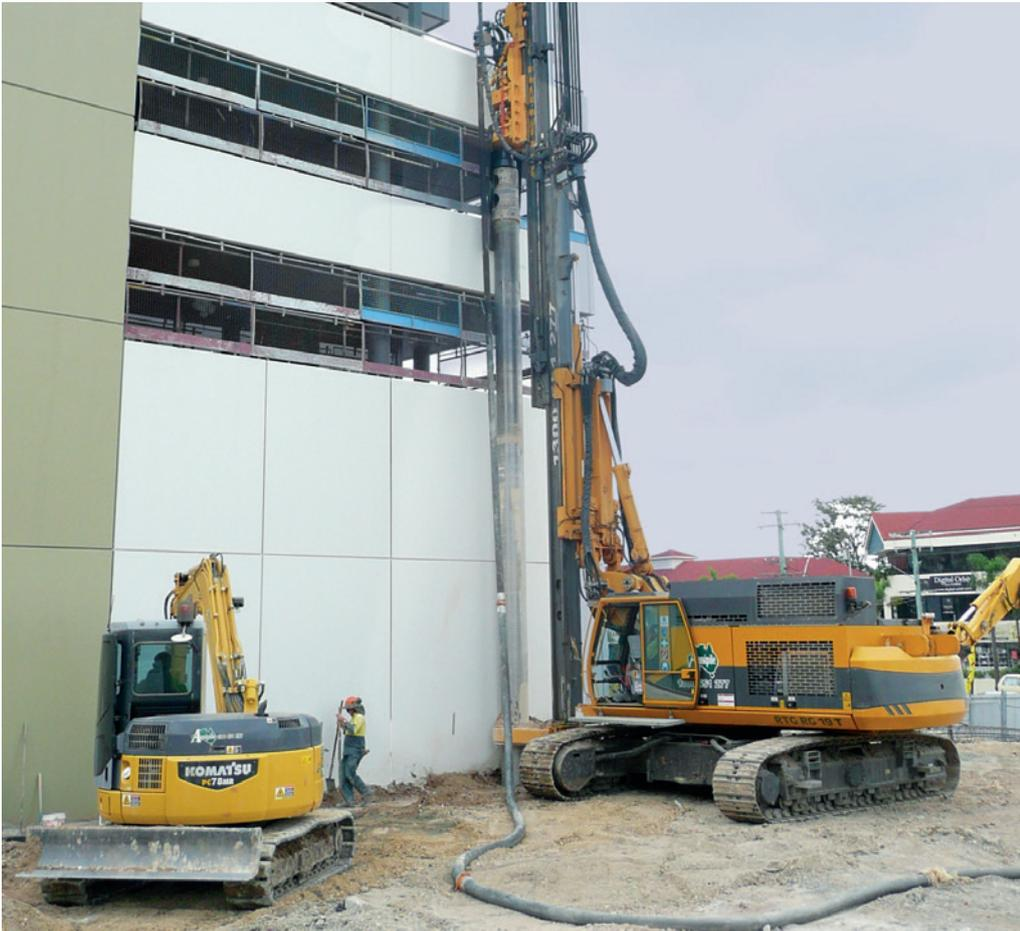
RG 19 T mit DKS 60/80 in VdW Anwendung | *RG 19 T with DKS 60/80 in FoW mode*
