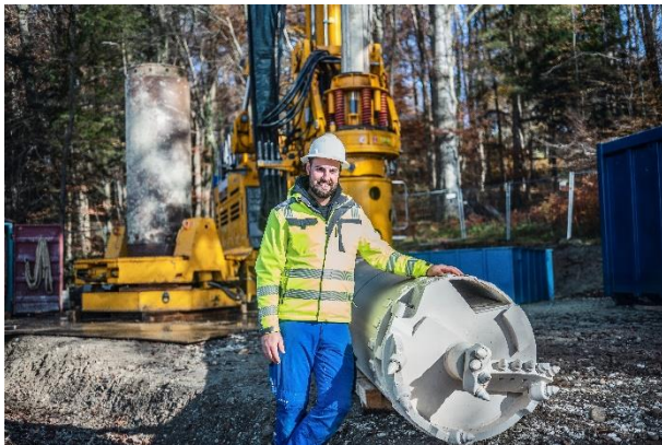
(3) Lucas Tafelmeier, Geschäftsführer bei Tafelmeier Tiefbrunnen-Bau, setzte auf die technische Leistungsfähigkeit der Bauer-Maschinen sowie die individuellen Bohrwerkzeuge von Bauer Parts & Service.
