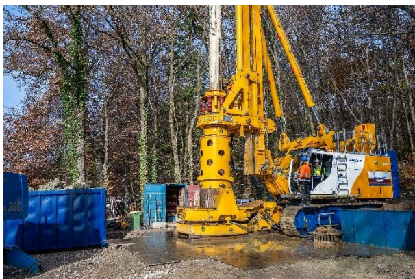
(4) Die besondere Herausforderung bei diesem Projekt: präzises Arbeiten in unterschiedlichen Bodenschichten bis hin zu Fels in einer beispiellosen Tiefe von 160 m.
