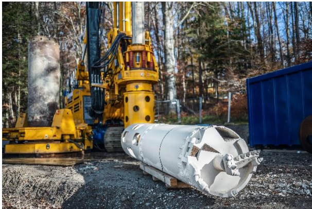
(2) Für das Projekt wurde ein eigens entwickelter Kastenbohrer KBF-K mit Führungsrohr verwendet.
