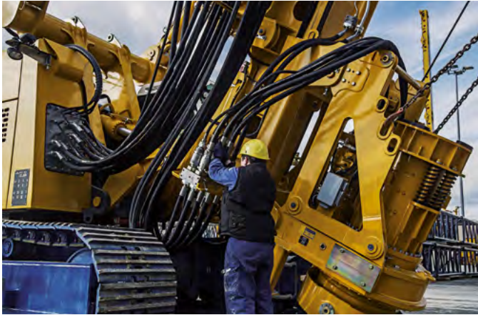
Aufbaustellung zum Anschluss der Hydraulikschläuche
