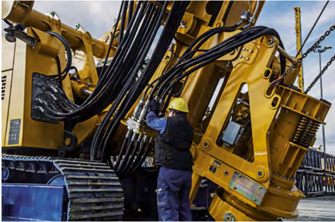
Aufbaustellung zum Anschluss der Hydraulikschläuche
