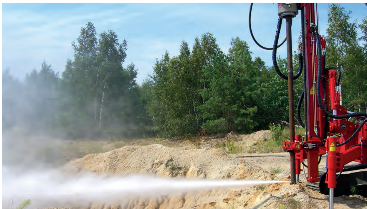
KLEMM HDI-Ausrüstung KLEMM jet grouting system
