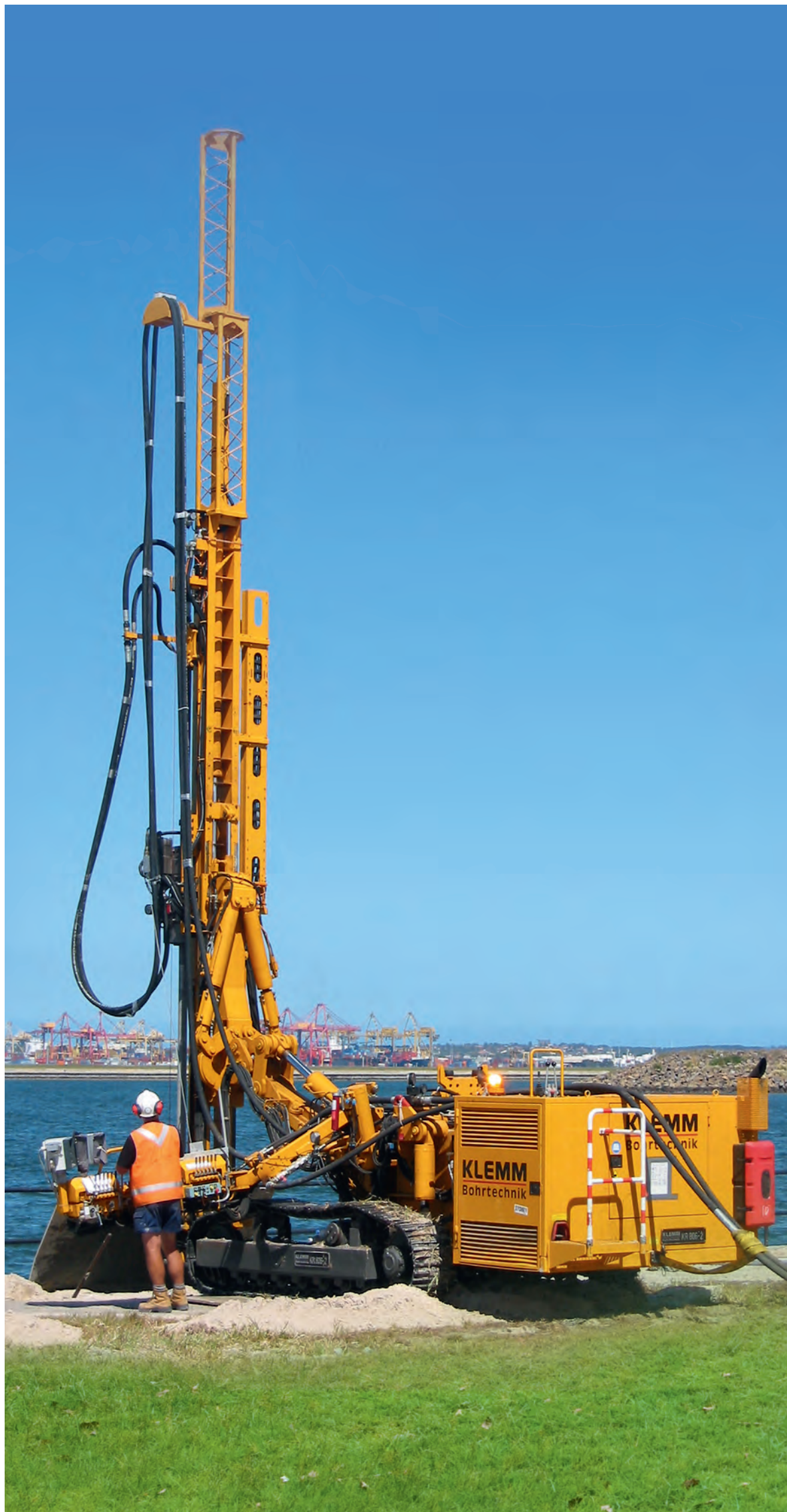
Hochdruckinjektionen High-pressure injections
