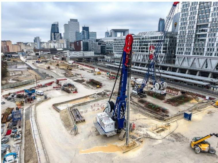
(1) Bis 2027 wird das BAUER BCS 185 power pack an mehreren neuen Stationen der Pariser Linie 15 zum Einsatz kommen, um Schlitzwandaarbeiten auszuführen.
