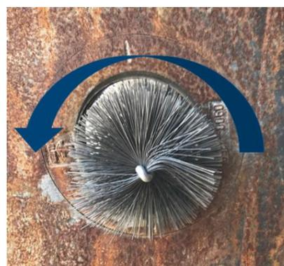
Abbildung 2: Drehrichtung Reinigungsbürste
