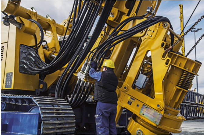
Aufbaustellung zum Anschluss der Hydraulikschläuche
