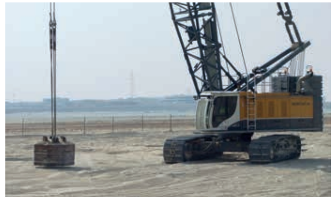
Fallhöhe 25 Meter, Fallgewicht 20 Tonnen
