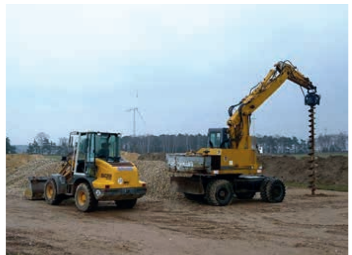
Vorbohren mit Schnecke
