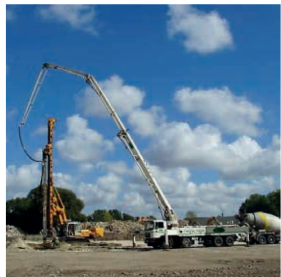
ROB-Säule, Betoniervorgang
