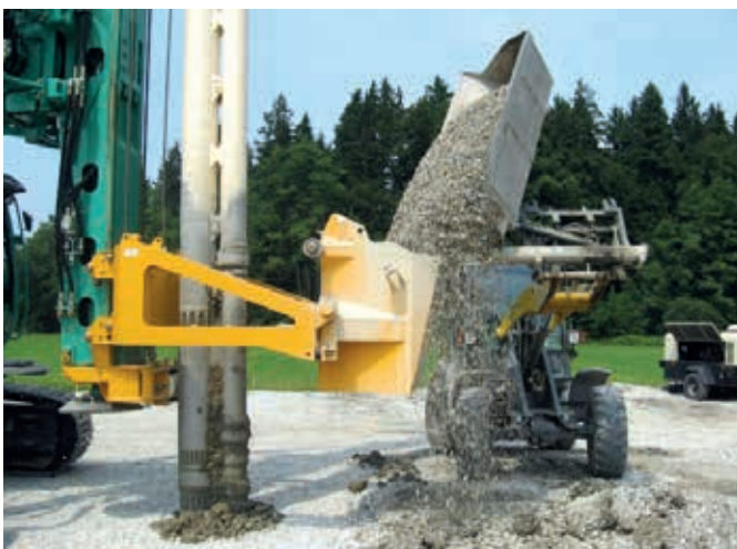
Befüllung über die Beschickungseinheit
