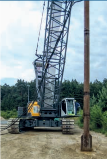
Rütteldruckverdichtung RDV
