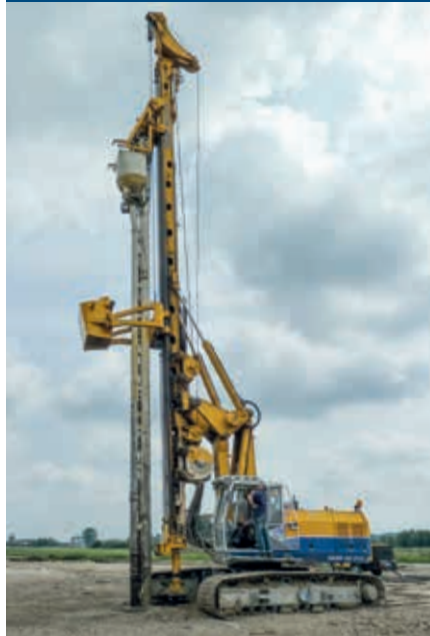
Rüttelstopfverdichtung RSV
