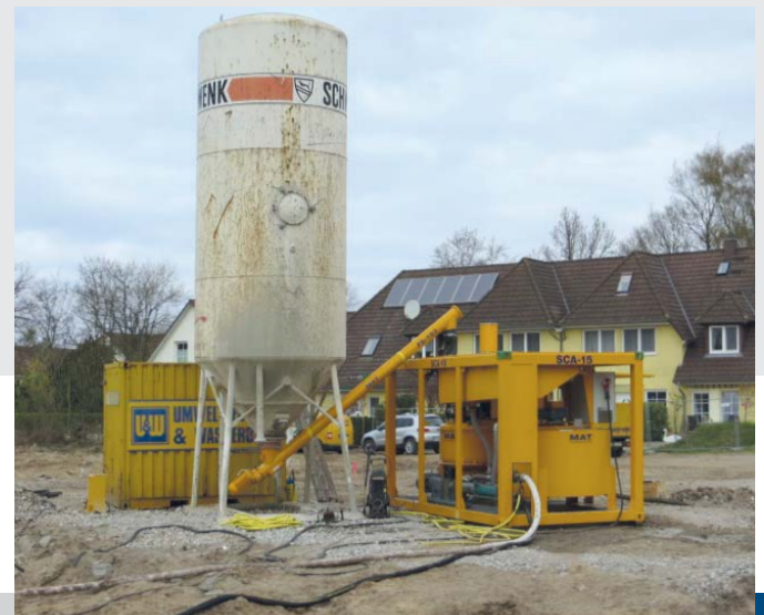
Kompaktmischanlage MAT SCA-15K inkl. Förderpumpe und Rührwerksbehälter
