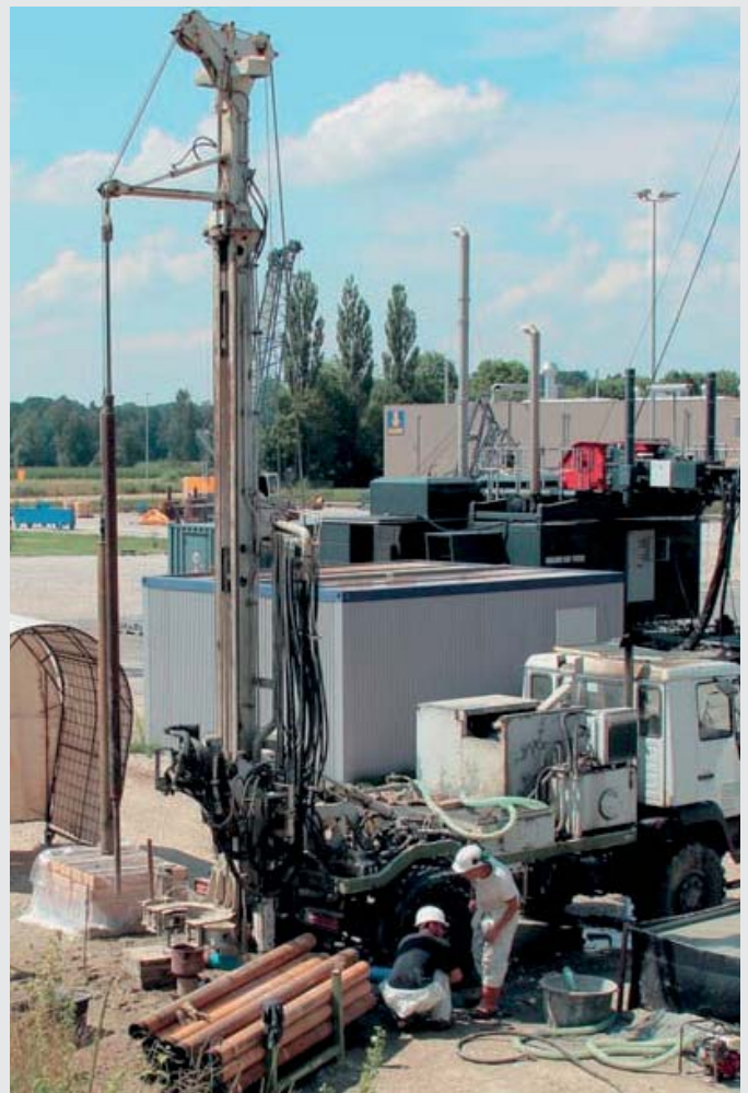
Vertikale Kernbohrung mit einem Bohrgerät für Aufschlussbohrungen
